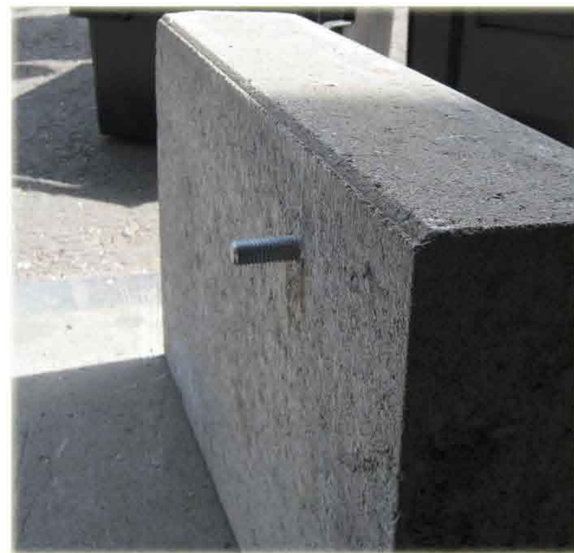
5. Kun massa on kovettunut, siisti reiän ympärys. Asenna profiili.
