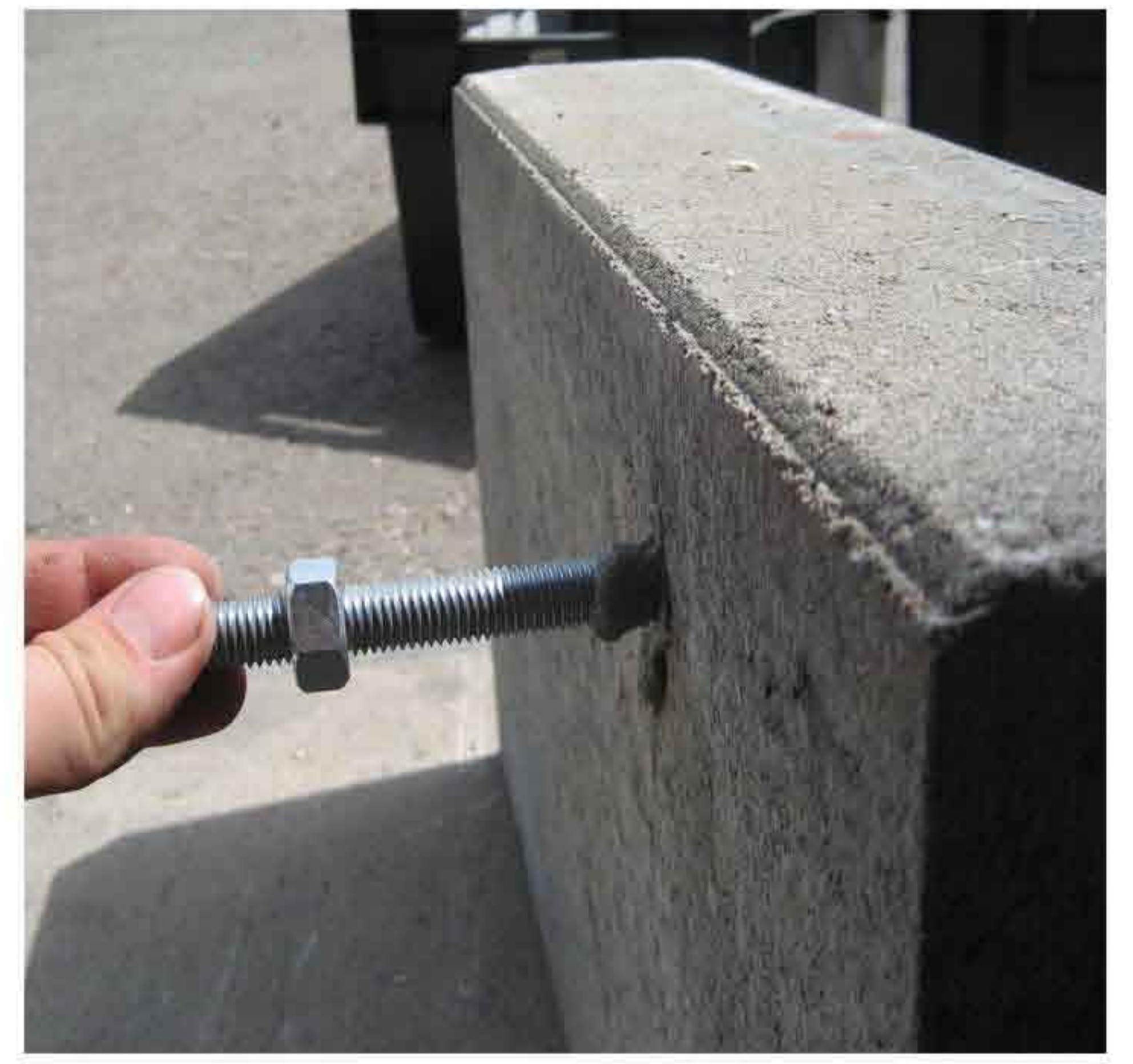
3. Aseta reikään kiinnike. (Esim. kierretanko tai vastaava)
