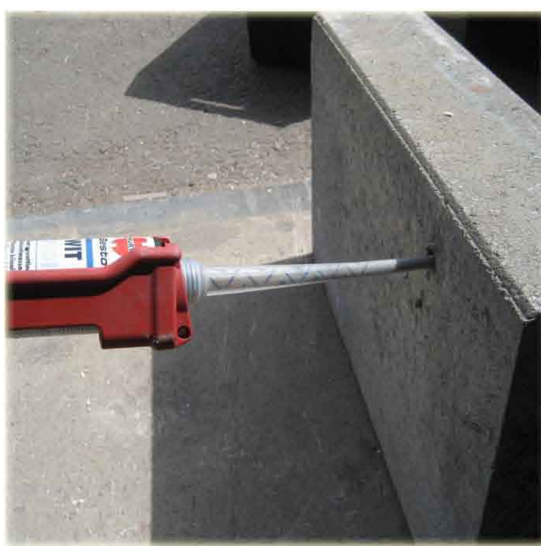
2. Putsaa reikä pölystä ja lisää injectiomassaa
